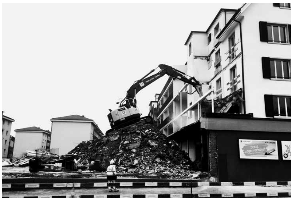
Abriss- und Aushubarbeiten an der Redingstrasse 43
