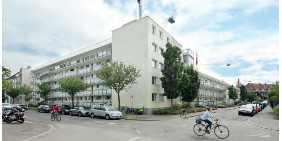
Siedlung Schützenmatte, Ecke Oberalpstrasse/General-Guisan-Strasse
