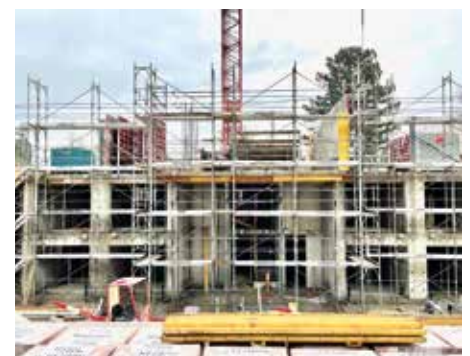
Die ersten Stockwerke stehen
