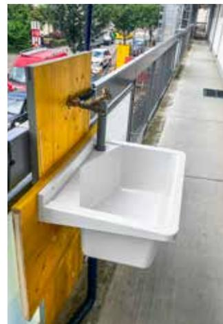
**Nach fünfzig Jahren mussten alle Leitungen ersetzt werden. Die Sanierung erfolgte in bewohntem Zustand, den Mietparteien standen Kochplatten und zentrale Zapfstellen für Kaltwasser sowie Auswechangebote zur Verfügung.**
