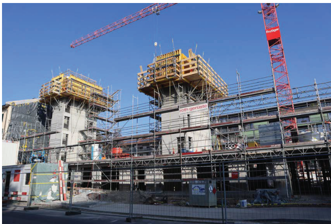
Die Baustelle läuft auf Hochtouren.
