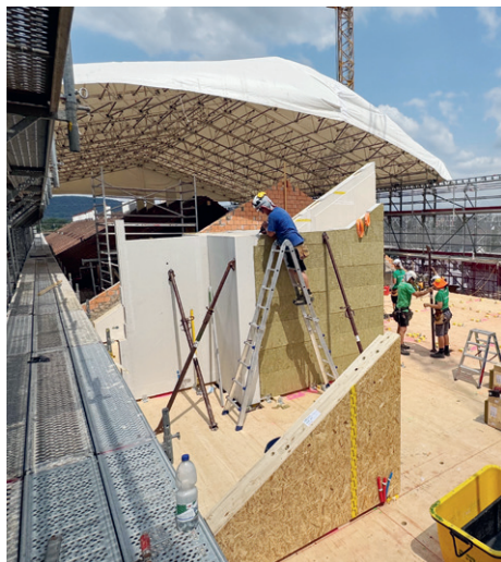
Neue Wände werden gestellt.
