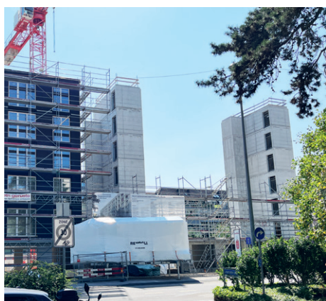
Treppenhäuser im Gerüst
